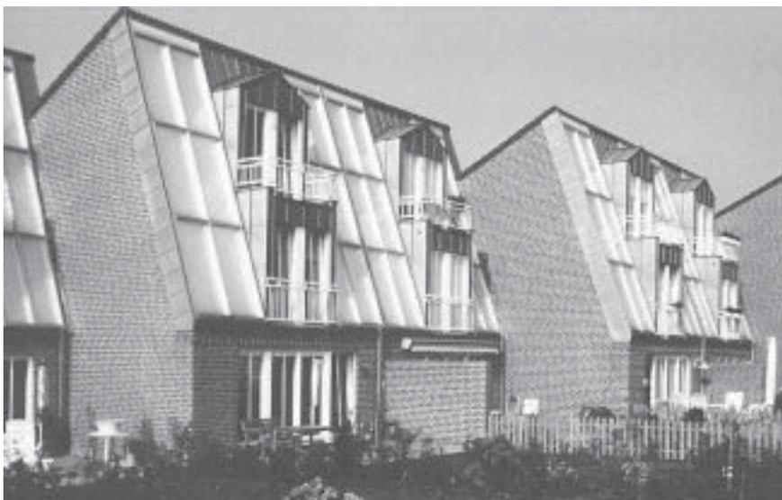
Abbildung 21 Transparente Wärmedämmung in der Praxis aus [54]
